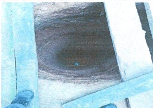
Foto 3: Reparación y mantenimiento de Sisternas/ depósito de Agua
