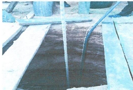
Foto 2: Reparación y mantenimiento de Sisternas/ depósito de Agua
