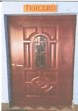
Foto 2.1: Suministro de puertas en todas las aulas posterior
