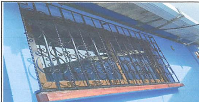
Foto 3.4: Mantenimiento y reparación de balcones posterior.
