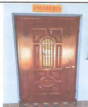
Foto 2.2: Suministro de puertas en todas las aulas posterior.
