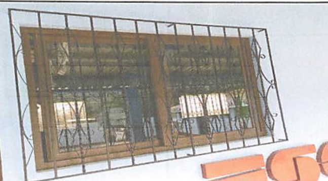
Foto 3.3: Mantenimiento y reparación de balcones posterior.
