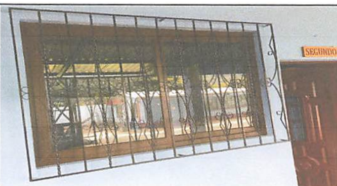
Foto 3.2: Mantenimiento y reparación de balcones posterior
