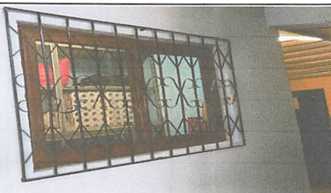
Foto 3.1: Mantenimiento y reparación de balcones posterior
