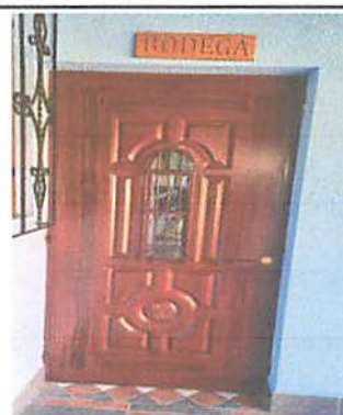
Foto 2.4: Suministro de puertas en todas las aulas posterior.
