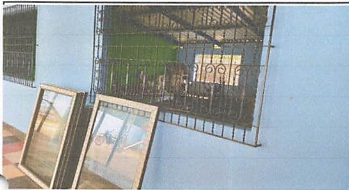
Foto 1.1: Suministro de ventanas durante.
