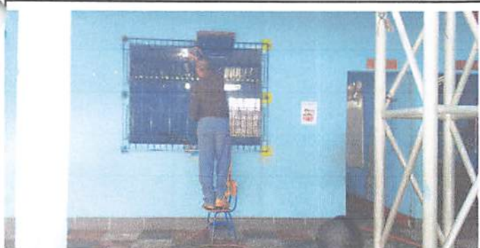
Foto 3.3: Mantenimiento y reparación de balcones durante.
