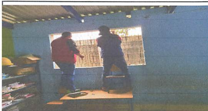
Foto 3.1: Mantenimiento y reparación de balcones durante.
