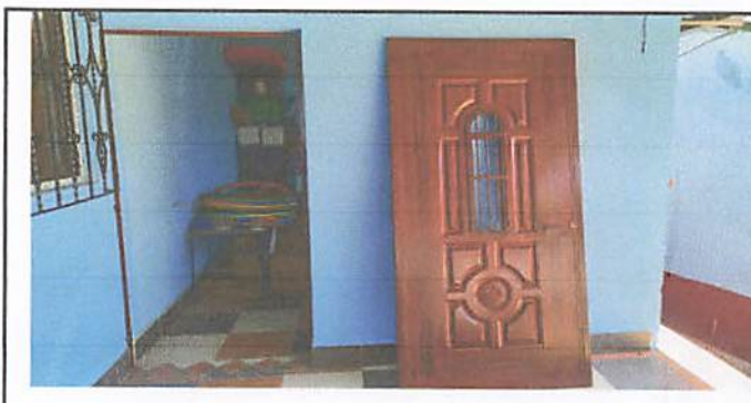
Foto 2.2: Suministro de puertas durante
