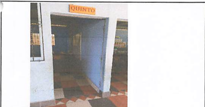
Foto 2.1: Suministro de puertas durante
