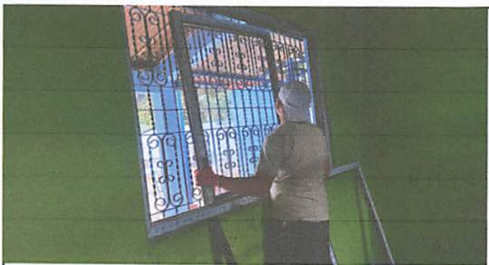
Foto 1.3: Suministro de ventanas durante.
