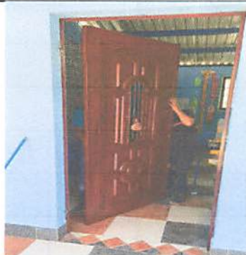
Foto 2.3: Suministro de puertas durante.
