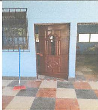
Foto 2.4: Suministro de puertas durante.
