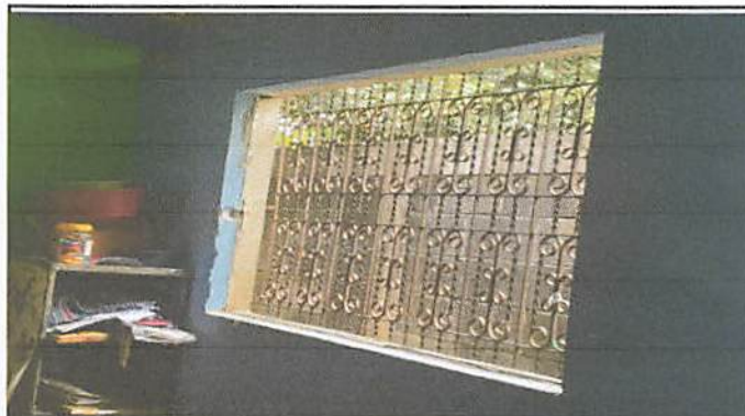
Foto 1.2: Suministro de ventanas durante.
