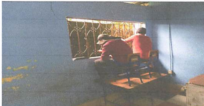
Foto 3.2: Mantenimiento y reparación de balcones durante.
