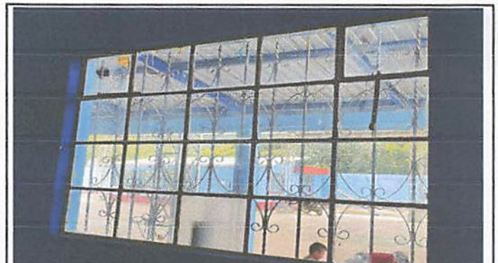
Foto 1.4: suministro de ventanas en todas las aulas.
