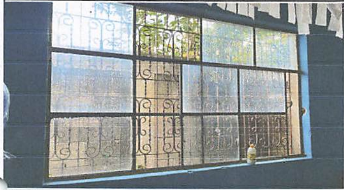
Foto 1.1: Suministro de ventanas en todas las aulas.
