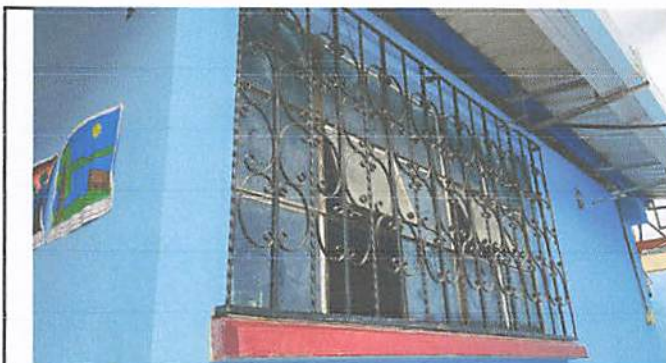
Foto 3.4: Mantenimiento y reparación de balcones.
