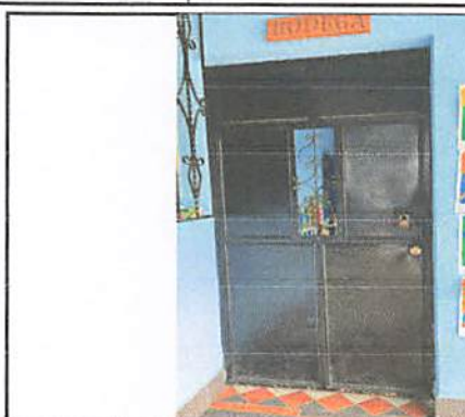
Foto 2.4: Suministro de puertas en todas las aulas
