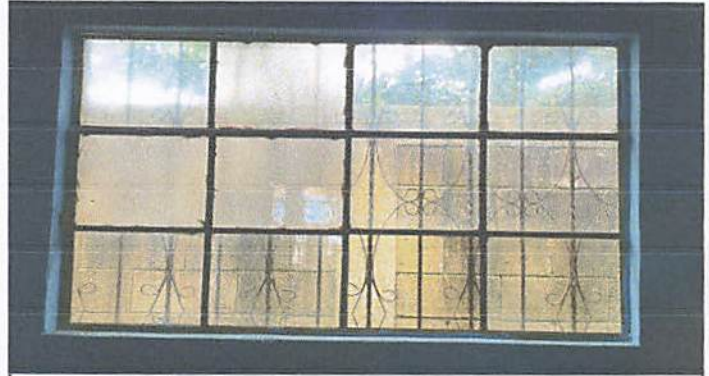
Foto 1.2: Suministro de ventanas en todas las aulas.
