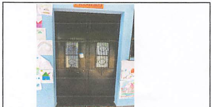
Foto 2.2: Suministro de puertas en todas las aulas.
