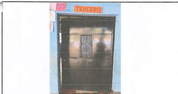
Foto 2.1: Suministro de puertas en todas las aulas.
