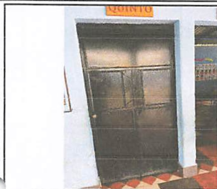
Foto 2.3: Suministro de puertas en todas las aulas.
