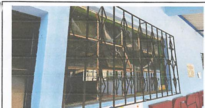
Foto 3.3: Mantenimiento y reparación de balcones.
