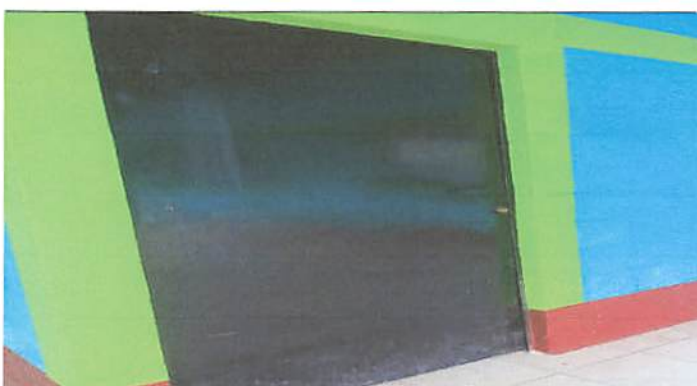
Foto 4: Pintada de las columnas y paredes exteriores ya terminada.
