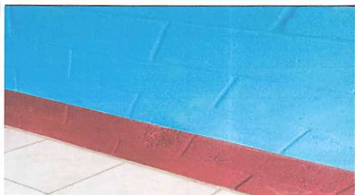
Foto 3: Pintada terminada de las aulas.
