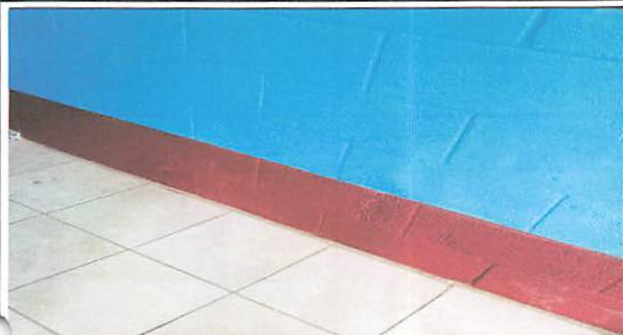
Foto 1: Aquí observamos la pintada terminada de las aulas.
