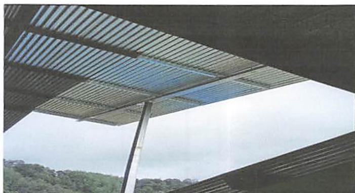
Foto 3: La parte del techado ya colocada.
