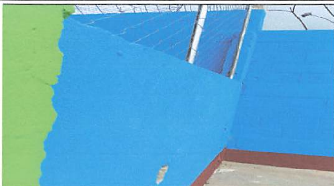
Foto 2: Así quedó la pintada de las pared de la parte interna del muro perimetral y de la maya galvanizada ya colocada.
