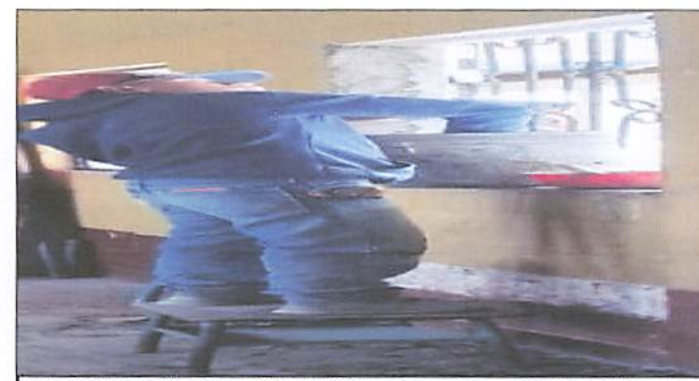
Foto 6: Colocación de ventana metálica por ventana corrediza PVC.
