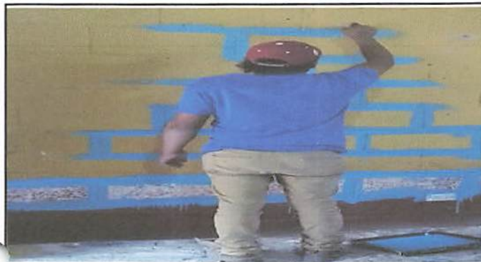
Foto1: Pintando ya las paredes interiores de la mayoría de las aulas despintadas.
