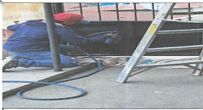
Foto 5: Trabajando la reparación del portón.
