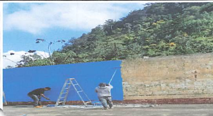
Foto1: Pintando ya las paredes exteriores del muro perimetral.
