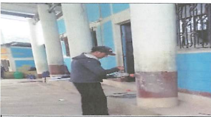
Foto 6: Iniciando la pintada de las columnas de corredores y de techado.
