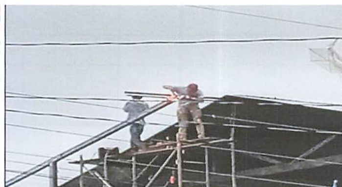
Foto 3: Colocación de rieles del techado.
