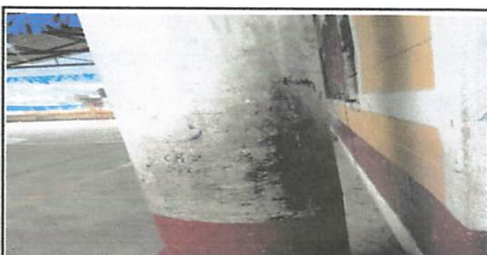
Foto 6: Pintura de columnas de corredores y de techado muy sucias y descoloridas.
