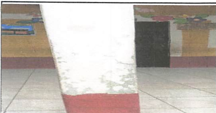
Foto 5: Columnas de los corredores, ya sin pintura la mayor parte y muy descascaradas.
