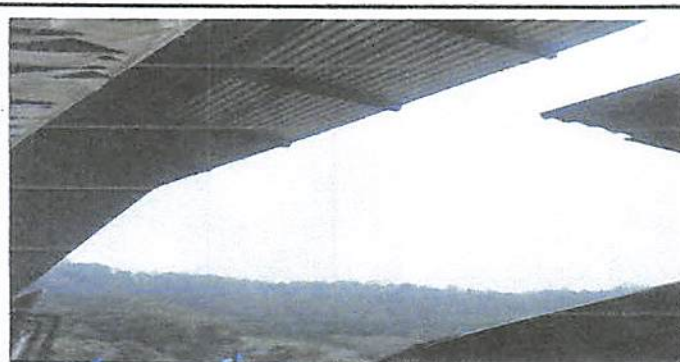
Foto 3: Ampliación de la parte del techado o cubierta para evitar que caiga el agua en el invierno, en la parte del corredor.
