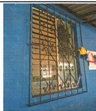
Foto 2: Mantenimiento a balcones de metal consistente en: Bajada de balcones, lijado, limpiado y aplicación de pintura anticorrosivo.
