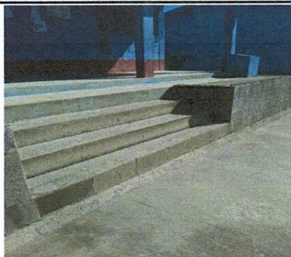
Foto 5: Sustrucción de gradas por rampa para ingreso en cocina.
