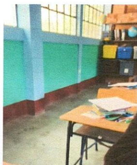
Foto 9: Instalación de sócalo en 3 aulas
