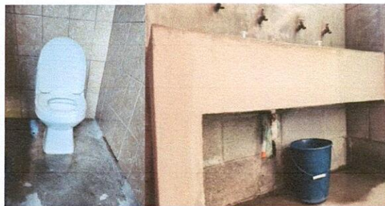
Foto 8: Reparación de inodoros y lavamanos
