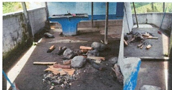
Foto 10: Nivelación, compactada de torta con fundición de 0.5cm
