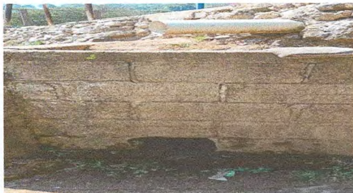
Foto 4: Reparación de bajada de agua pluvial.
