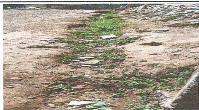
Foto 3: Reparación de cunetas de concreto.
