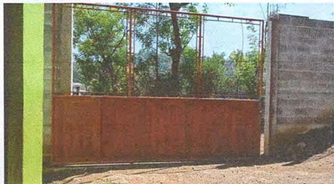
Foto 1: Mantenimiento a portón de metal.
