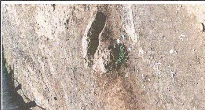
Foto 2: Reparación de plancha de concreto de patio.
