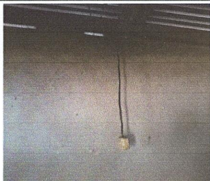
Foto 9: Suministro e instalación de sistema eléctrico de cocina
