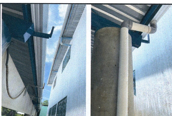
Foto6: Finalizan trabajos de sustitución de canal y bajadas pluviales tubo PVC de 3" y accesorios, se realiza prueba de filtración para garantizar el funcionamiento del mismo
