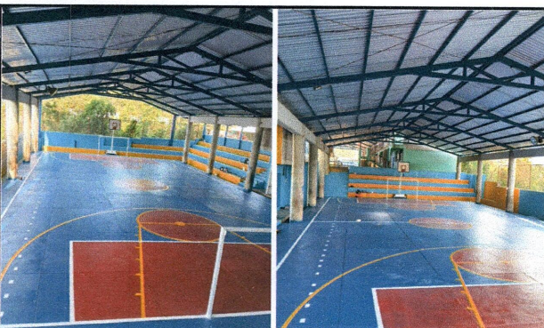
Foto5: Finalización de trabajos de sustitución de lámina, se finaliza la aplicación de pintura base color blanco y acabado final azul anticorrosiva en estructura metálica
