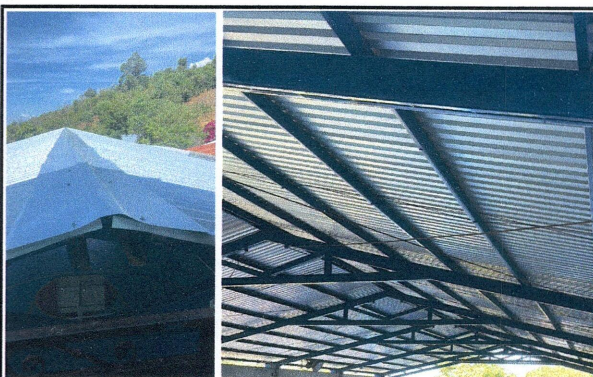
Foto4: Finalización de trabajos de sustitución de lámina, se finaliza la aplicación de pintura base color blanco y acabado final azul anticorrosiva en estructura metálica
