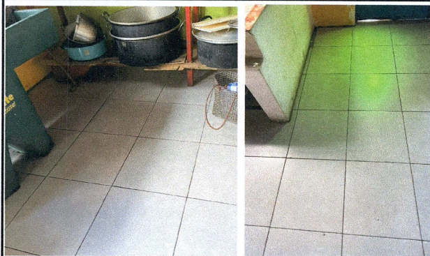
Foto 1: Se finalizan trabajos en cocina, suministro e instalación de piso cerámico
