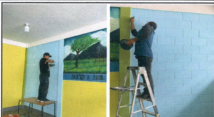
Foto2: Avance de trabajos de aplicación de pintura impermeabilizante en aulas, eliminación total de hongo
