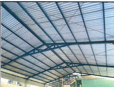
Foto 5: Avanzan trabajos de sustitución de lámina
