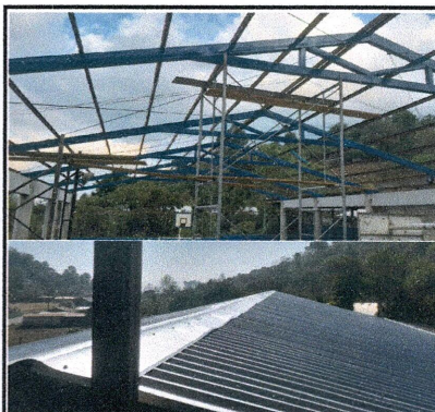
Foto 3: Se comienza con el mantenimiento de la estructura metálica, así mismo la colocación de lámina troquelada calibre 26, de 28 pies de largo, se verifica que todo esté alineado y se coloca atornillado a la estructura metálica
