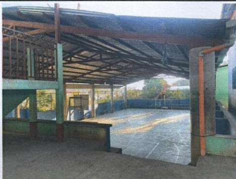
Foto 5: Cubierta de lámina de cancha deteriorada y con filtraciones de agua pluvial, area a cubri 32.05mts x 16.00mts
