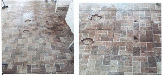
Foto 2: SUSTITUCION DE PISO ANTIDESLIZANTE A PISO CERAMICA ACABADO MATE.
