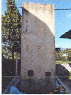
Foto 1: SUSTITUCION DE DEPOSITO A DEPOSITO AEREO CON LAVAMANOS EN LA PARTE INFERIOR.
