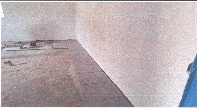
Foto 7: SUMINISTRO E INSTALACIÓN DE PISO CERÁMICO EN LABORATORIO DE COMPUTACIÓN (Incluye instalación de zócalo).
