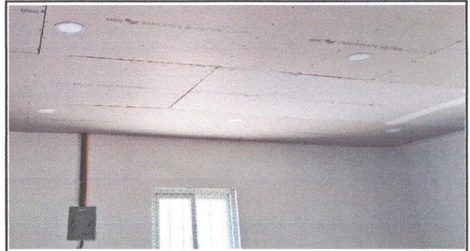
Foto 8: MANTENIMIENTO Y TALLADO DE PAREDES + SUMINISTRO Y APLICACIÓN DE ACABADO ALISADO EN LABORATORIO DE COMPUTACIÓN.
