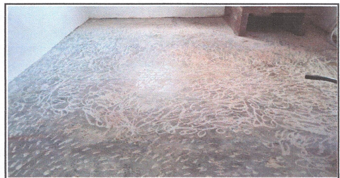
Foto 12: SUMINISTRO E INSTALACIÓN DE PISO CERÁMICO EN COCINA (Incluye instalación de zócalo).
