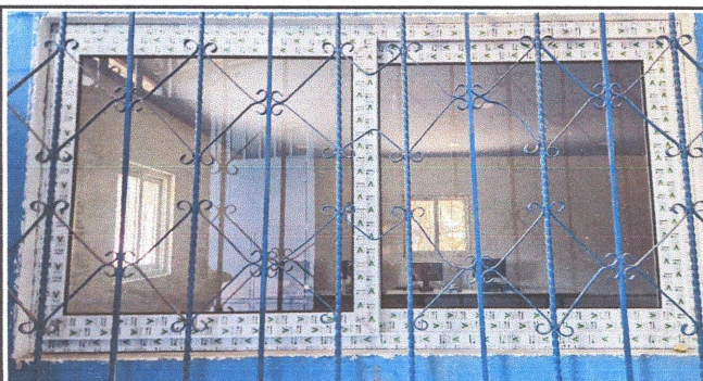
Foto 11: SUMINISTRO E INSTALACIÓN DE VENTANAS PVC (Serie 60).
