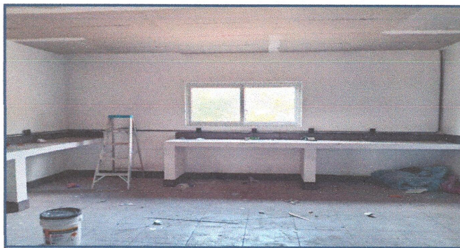
Foto 5: SUMINISTRO E INSTALACIÓN DE VENTANAS PVC (Serie 60).
