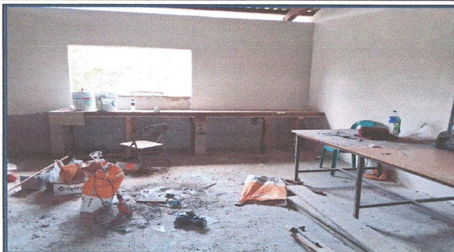
Foto 1: SUMINISTRO E INSTALACIÓN DE PISO CERÁMICO EN LABORATORIO DE BIOLOGÍA (Incluye instalación de zócalo).
