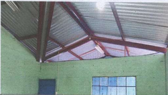
Foto 9: SUMINISTRO E INSTALACIÓN DE PLAFÓN CORRIDO (Cielorraso) + INSTALACIÓN DE ILUMINACIÓN EN LABORATORIO DE COMPUTACIÓN (Incluye instalación de cableado desde centro de carga).
