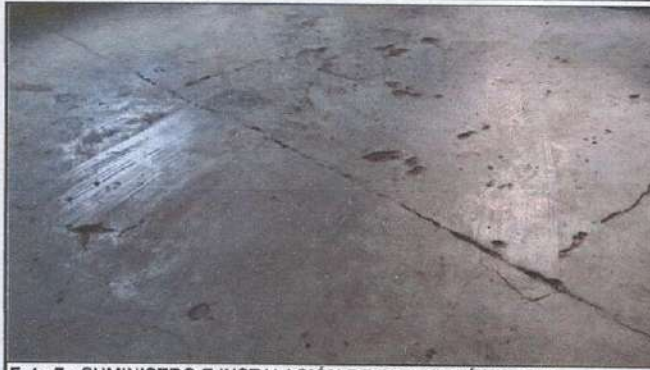
Foto 7: SUMINISTRO E INSTALACIÓN DE PISO CERÁMICO EN LABORATORIO DE COMPUTACIÓN (Incluye instalación de zócalo).
