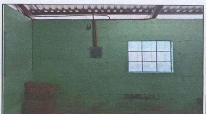
Foto 10: INSTALACIÓN DE TUBERÍA Y TOMACORRIENTES EXPUESTOS EN LABORATORIO DE COMPUTACIÓN (Incluye instalación de cableado desde centro de carga).
