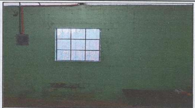
Foto 8: MANTENIMIENTO Y TALLADO DE PAREDES + SUMINISTRO Y APLICACIÓN DE ACABADO ALISADO EN LABORATORIO DE COMPUTACIÓN.
