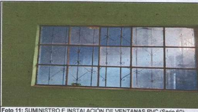
Foto 11: SUMINISTRO E INSTALACIÓN DE VENTANAS PVC (Serie 60).
