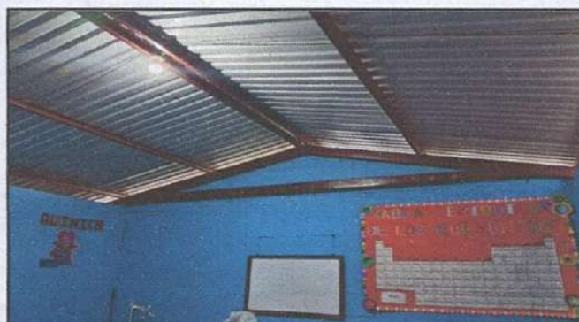
Foto 4: SUMINISTRO E INSTALACIÓN DE PLAFÓN CORRIDO (Cielorraso) + INSTALACIÓN DE ILUMINACIÓN EN LABORATORIO DE BIOLOGÍA (Incluye instalación de cableado desde centro de carga).
