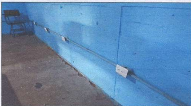
Foto 3: INSTALACIÓN DE TUBERÍA Y TOMACORRIENTES EXPUESTOS EN LABORATORIO DE BIOLOGÍA (Incluye instalación de cableado desde centro de carga).
