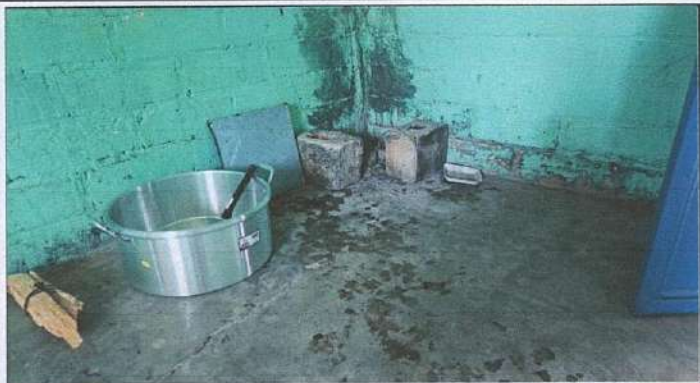
Foto 13: REPARACIÓN Y MANTENIMIENTO DE ESTUFA ARTESANAL, CORRECCIÓN DE SALIDA DE HUMO.
