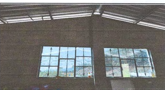
Foto 2.2: Las paredes de la cocina necesitan cernido en el área interior
