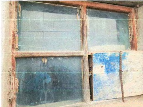
Foto 2: Sustrucción de balcones.
