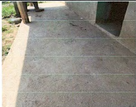
Foto 7: Reparación de planchas de concreto de patio.
