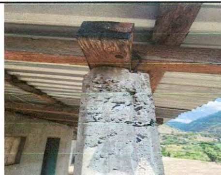
Foto 6: Reparación de columnas para corredor de dirección.
