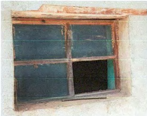
Foto 1: Sustrucción de estructura de metal de ventana.
