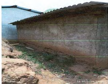
Foto 5: Reparación de cernido de paredes.
