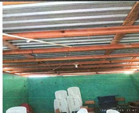
Foto 4: Estructura de techo de dirección.
