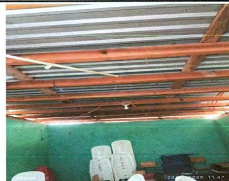
Foto 10: Sustitución de lámpara tipo led.
