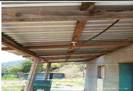
Foto 13: Sustitución de techo por lámina troquelada calibre 26.
