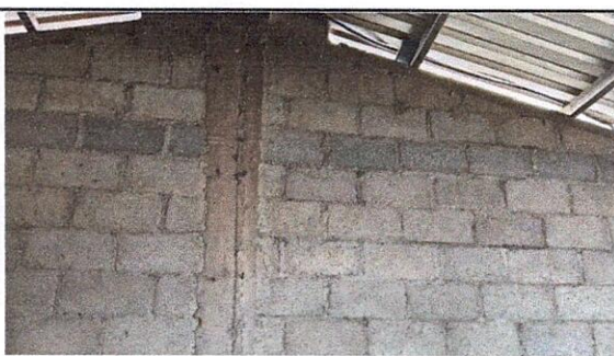
Foto 5: Aplicación de pintura de la cocina.
