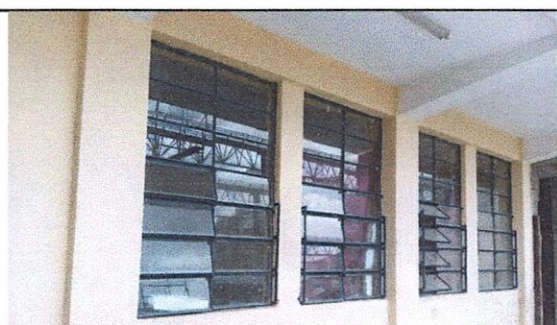
Foto 6: Instalación de Balcones.
