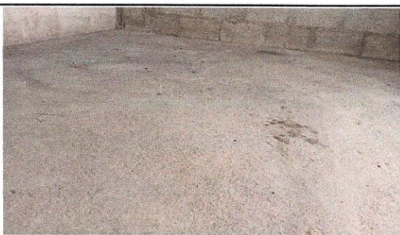
Foto 3: Instalación de Piso de Granito en la cocina.
