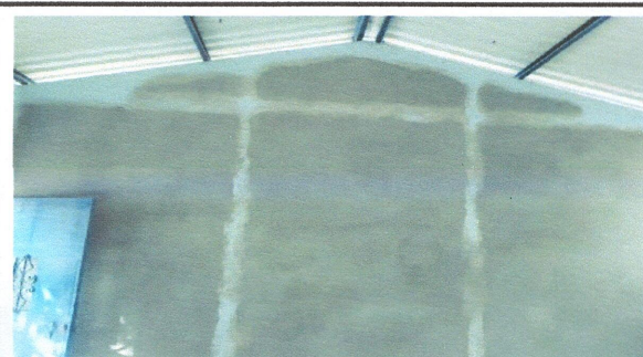
CERNIDO EN MURO INTERIOR Y EXTERIOR
