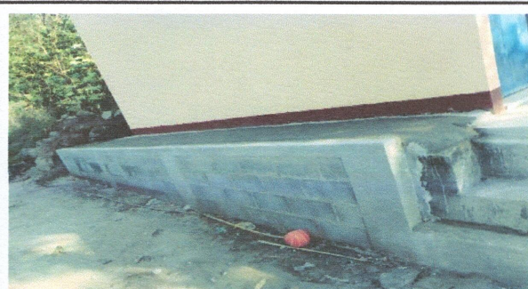
PROTECCION DE TALUD EN AULA A TRAVES DE MURO DE CONTENCIÓN CONSISTENTE EN: ELABORACION DE ZAPATA, CAITE, COLUMNAS, FUNDICIÓN DE COLUMNAS, LEVANTADO Y SISADO DE
