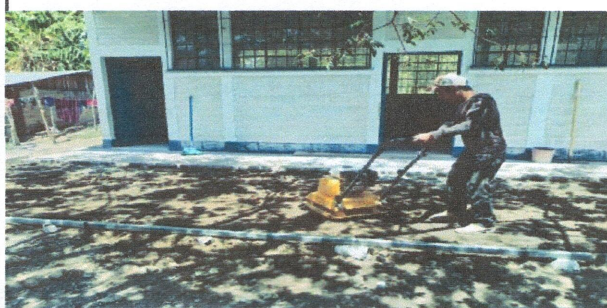
REPARACION DE PLANCHAS DE CONCRETO DE PATIO DE AULA
