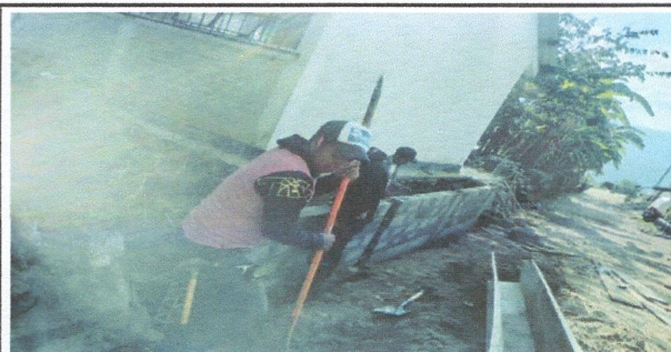
PROTECCION DE TALUD EN AULA A TRAVES DE MURO DE CONTENCIÓN CONSISTENTE EN: ELABORACION DE ZAPATA, CAITE, COLUMNAS, FUNDICIÓN DE COLUMNAS, LEVANTADO Y SISADO DE
