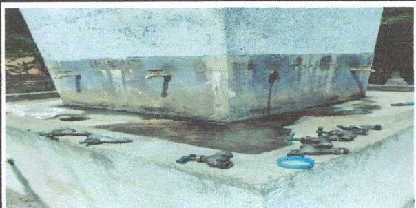
SUSTITUCION DE LLAVE DE CHORROS
