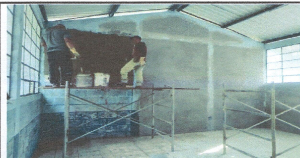
CERNIDO EN MURO INTERIOR Y EXTERIOR
