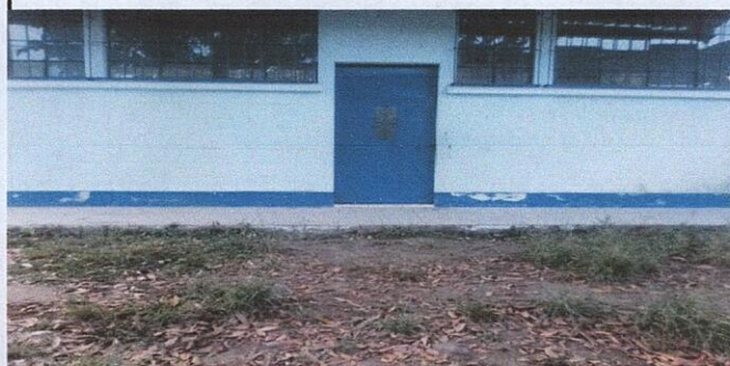
CERNIDO EN MURO INTERIOR Y EXTERIOR
