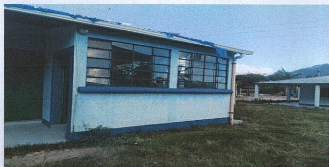
REPARACION DE PLANCHAS DE CONCRETO DE PATIO
