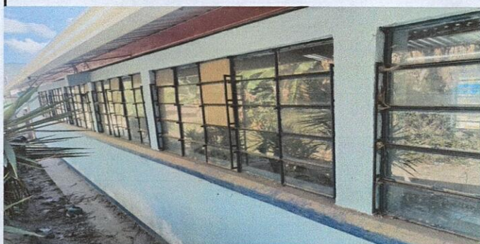
FABRICACION E INSTALACION DE BALCONES DE HIERRO EN VENTANAS PARA DOS AULAS, DIRECCION Y BODEGA
