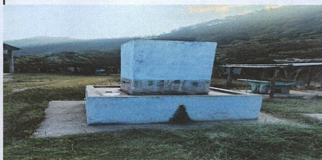
SUSTITUCION DE LLAVE DE CHORROS
