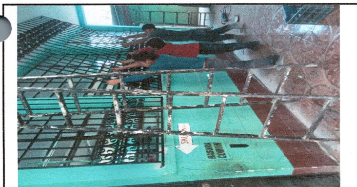
Foto 5: Suministro e instalación de balcones de ventanas para aula 1.20x 1.85
