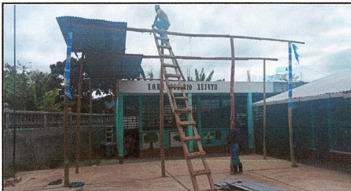
Foto 1: Suministro e instalación de techo con láminas troqueladas calibre 26 aluzinc para área de comedor y sala de reuniones de padres de familia
