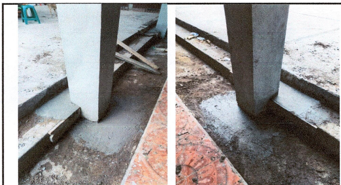
Foto 3: Elaboración de columnas para soporte de techado consistentes en: fundido, cernido y desencofrado de 20x20 cm x 2 metros
