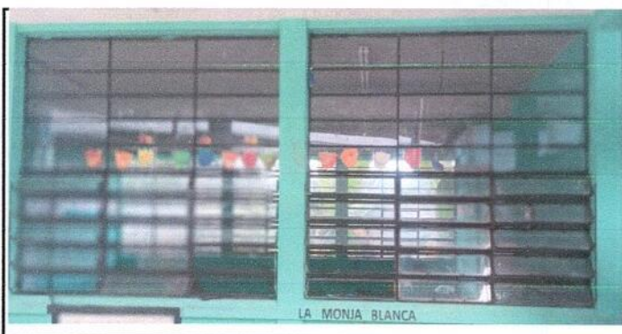
Foto 6: Suministro e instalación de balcones de ventanas para aula 2.36x1.85
