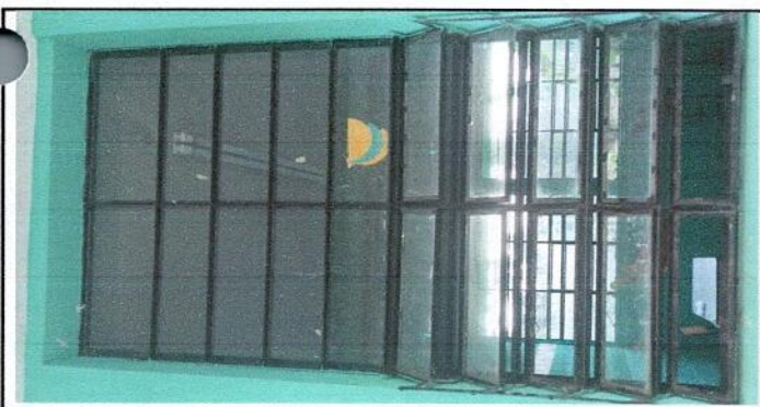
Foto 5: Suministro e instalación de balcones de ventanas para aula 1.20x 1.85
