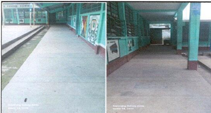
Foto 4: Sustitución de piso de cemento con piso cerámico samboro
