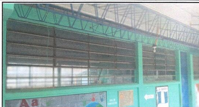
Foto 1: Suministro e instalación de balcones de ventanas para aula 3.55 x 1.20
