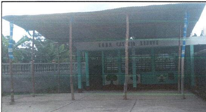
Foto 2: Suministro e instalación de estructura de techo con tubo galvanizado de 6x2 y 2x4 chapa 14, para área de comedor y sala de reuniones de padres de familia
