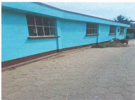
1. Pintura en muros exteriores e interiores de seis aulas, dirección, bodega y cocina
