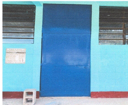
2. Mantenimiento a estructura de puertas con chapa de metal consistente en: (lijado, limpieza aplicación de pintura. Altura 309 cm ancho 103 cm).
