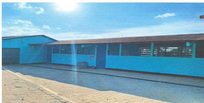
3. Losa de patio consistente en: Instalación de planchas de adoquin decorativo.
