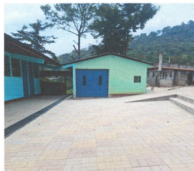
6. Apertura de nueva puerta en obra gris a cocina existente.
