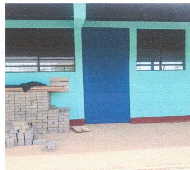
2. Mantenimiento a estructura de puertas con chapa de metal consistente en: (lijado, limpieza aplicación de pintura. Altura 309 cm ancho 103 cm).
