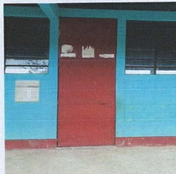
2. Mantenimiento a estructura de puertas con chapa de metal consistente en: (lijado, limpieza aplicación de pintura. Altura 309 cm ancho 103 cm
