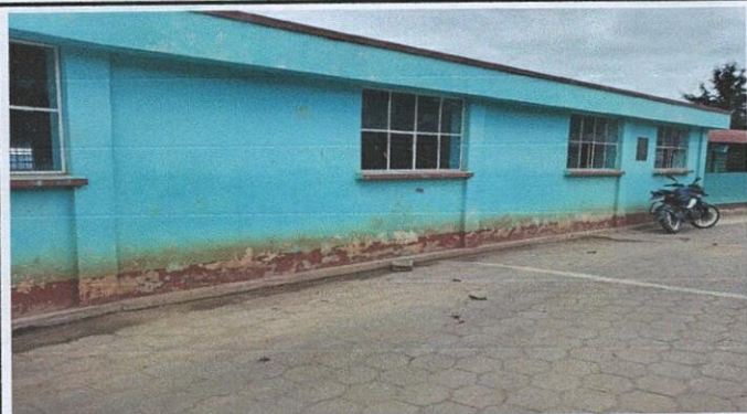
1. Pintura en muros exteriores e interiores de seis aulas, dirección, bodega y cocina
