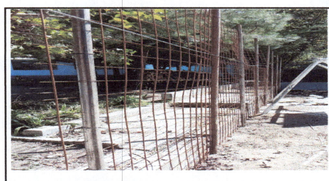
Foto 6: COLOCACIÓN DE MAYA
