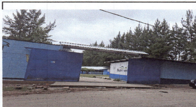
Foto 1: COLOCACIÓN DE PORTON Y ARREGLO DE BANQUETA EN LA PARTE DE LA CALLE
