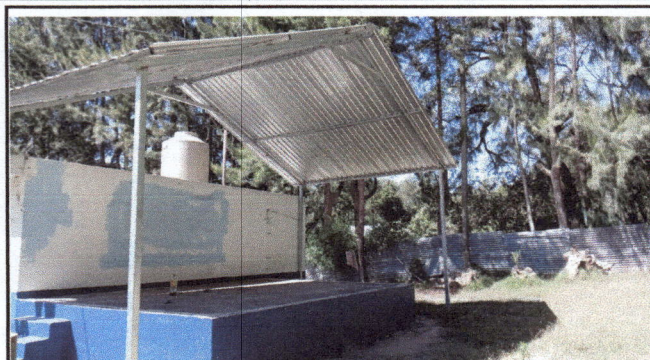
Foto 2: COLOCACION DE TECHO
