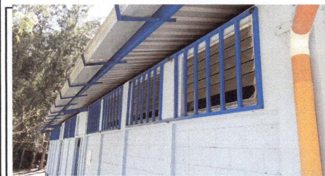
Foto 5: COLOCACION DE BALCONES EN AULA
