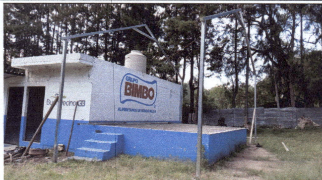
Foto 2: COLOCACION DE TECHO
