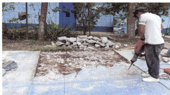
ARREGLO DE PLANCHA DE CEMENTO EN CANCHA
