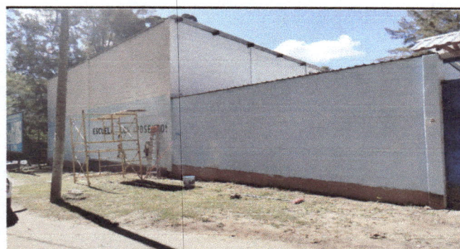
Foto 6: COLOCACION DE PINTURA
