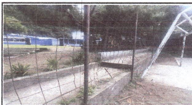
Foto 6: 30 ml de sustitución de elctromalla y tubos en área de cancha polideportiva
