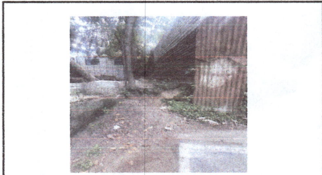
Foto 10: 20 ml de muro de contención colindante con vecino
