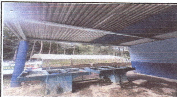
Foto 15: 13 m2 de techado de lámina con estructura metálica en área de pilas.
