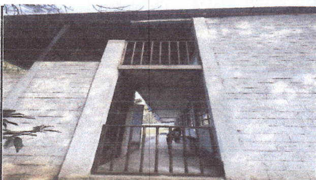
Foto 16: 2 m2 de techado de lámina con estructura metálica en área de pasillos.
