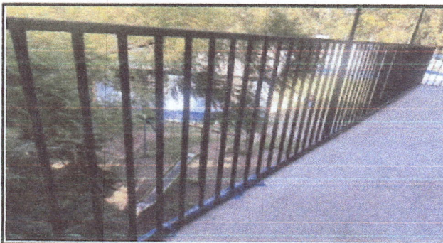
Foto 5: Mantenimiento de 18 ml de barandas de 1.5 m de alto, lijado, pintado
