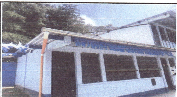
Foto 17: Cambio de 8.30 ml de canales
