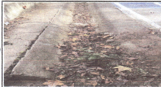
Foto 11: 4.5 m2 de reparación de torta de cemento para cuneta de desvío de aguas pluviales en área de cancha polideportiva
