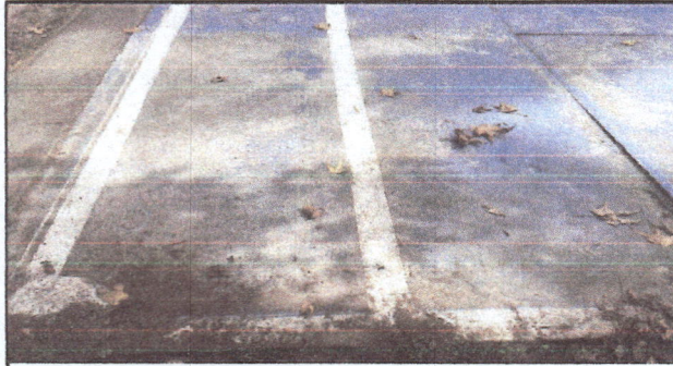
Foto 7: Demolición de torta dañada en área de cancha polideportiva y cuneta de desvío de aguas pluviales
