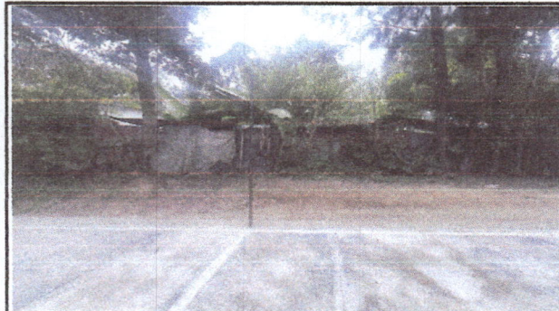
Foto 9: 25 ml de sanjeo en área de levantado de muro de contención y gradas
