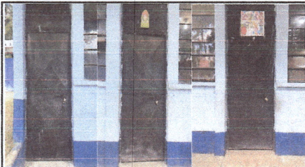
Foto 20: Mantenimiento de 3 puertas metálicas en área de salones
