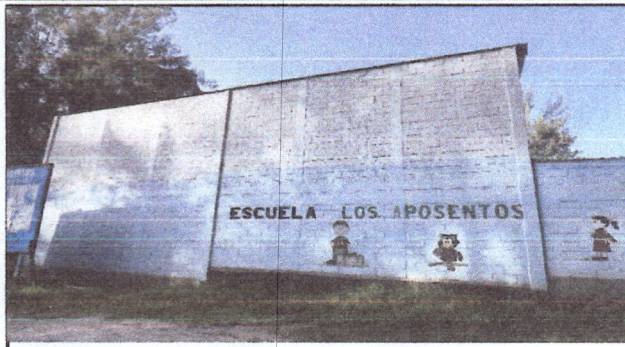
Foto 2: 279 m2 de aplicación de pintura en fachada
