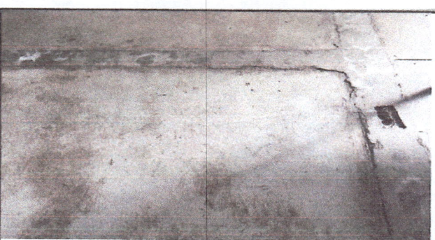
Foto 18: 28 m2 de Demolición, nivelación y fundición de entrepiso
