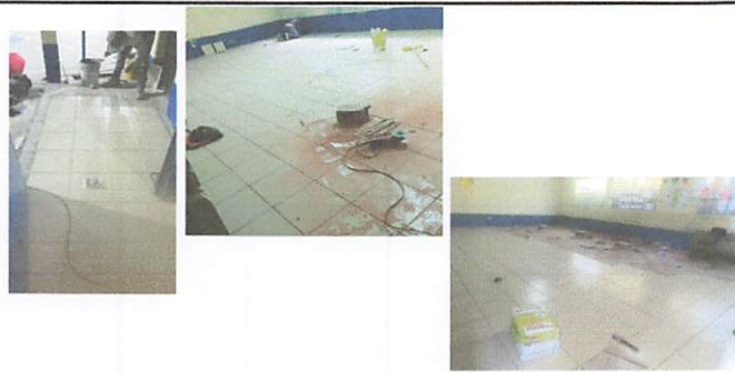
Instalación de piso en 2 salones
