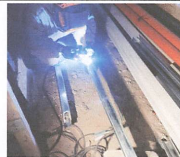
Soldando los Balcones
