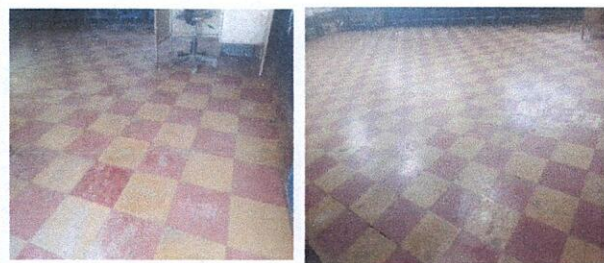
Instalación de piso en 2 salones
