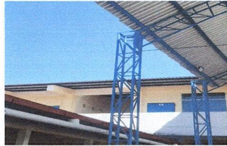
Canales de Techado
