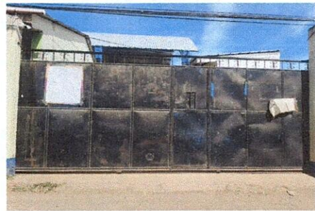
Mantenimiento a portón
