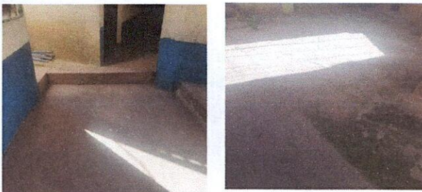
Fundición de torta frente a cocina
