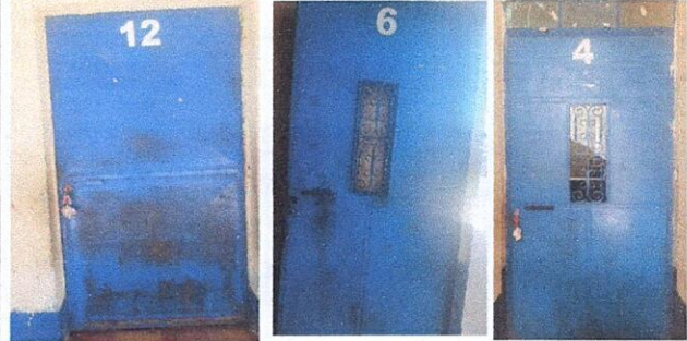
Mantenimiento de 3 puertas
