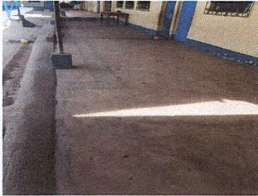
instalación de piso antideslizante, corredor
