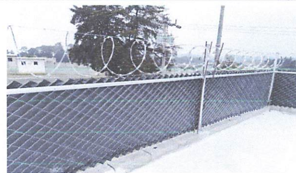
FOTO 5: VISTA FINAL DE PRIVACINTA Y CERCO PERIMETRAL CON RAZON RIBBON
