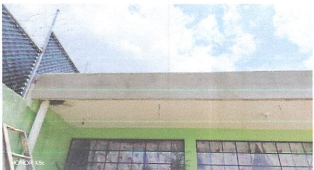
FOTO 2: VISTA FINAL DE BAJADA DE AGUA PLUVIAL
