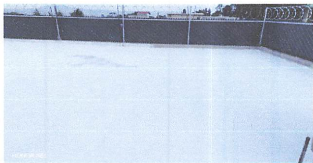
FOTO 1: LOSA CON IMPERMEABILIZANTE APLICADO
