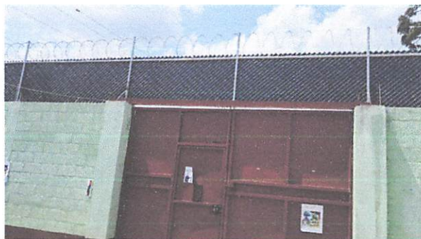
FOTO 6: VISTA FINAL DE CERCO PERIMETRAL DE MALLA GALVANIZADA CON TUBO DE 1 1/2" CON PRIVACINTA DE COLOR VERDE Y RAZOR RIBBON
