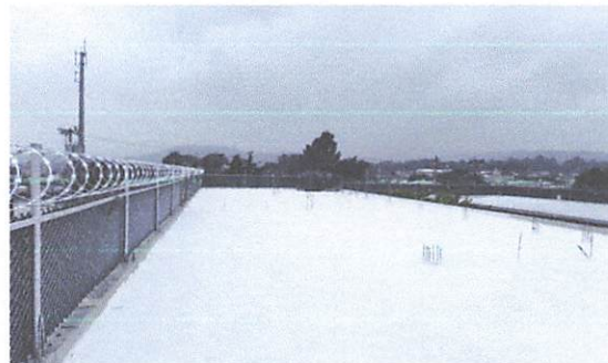
FOTO 4: VISTA FINAL DE LOSA TERMINADA CON IMPERMEABILIZANTE
