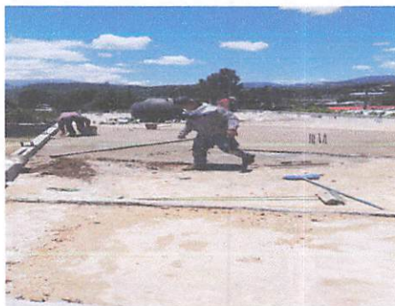
FOTO 1: Picado, limpieza y remoción de desechos del exterior de losa
