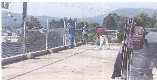
FOTO 3: Instalación de cerco perimetral con tubo galvanizado de 1 1/2" y malla galvanizada
