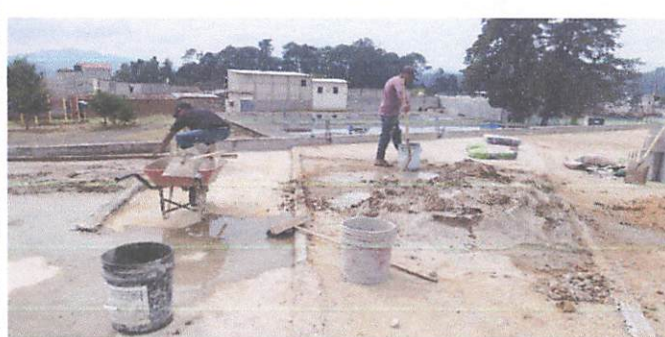
FOTO 5: Nivelado de mezcla especial en losa
