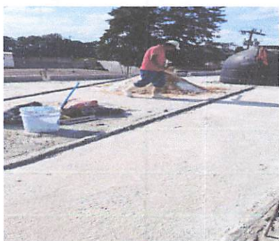
FOTO 2: Suministro, fabricación y vertido de mezcla especial de concreto para relleno en losa exterior
