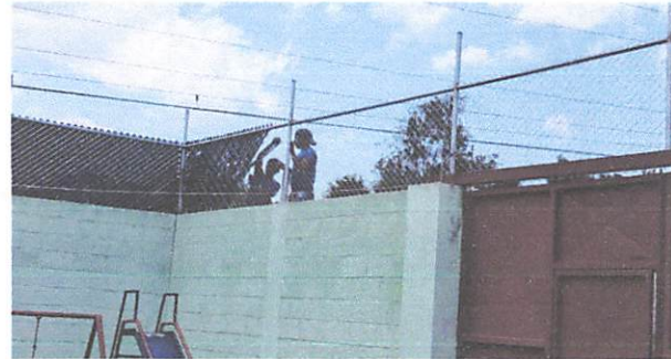
FOTO 6: Instalación de privacinta en cerco perimetral de malla galvanizada
