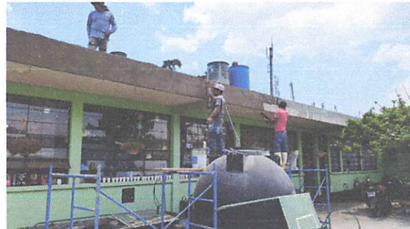
FOTO 4: Alisado de muro de block
