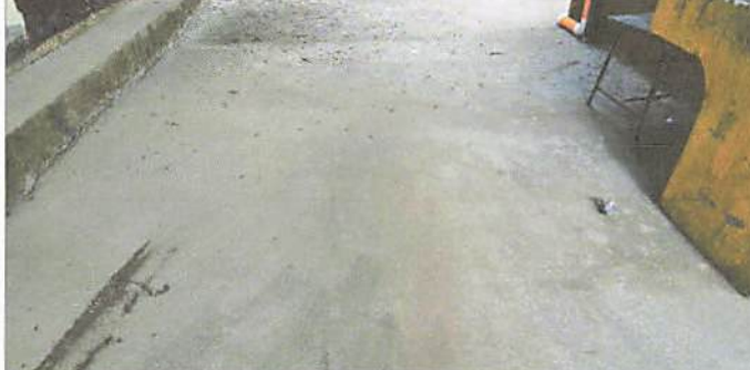
TERMINACION DE PAVIMENTADO
