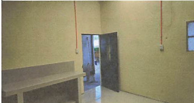
COLOCACION DE PISO Y MESA DE CONCRETO DECORADA CON AZULEJO
