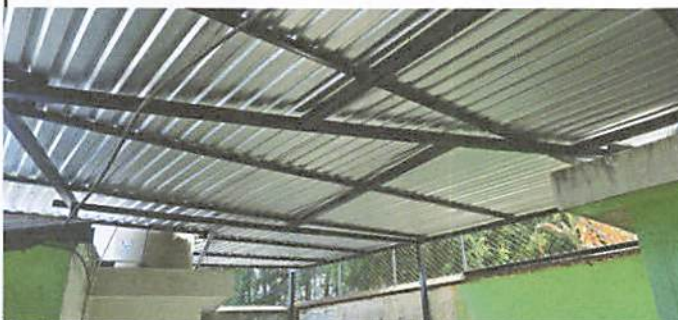
TERMINACION DE TECHADO
