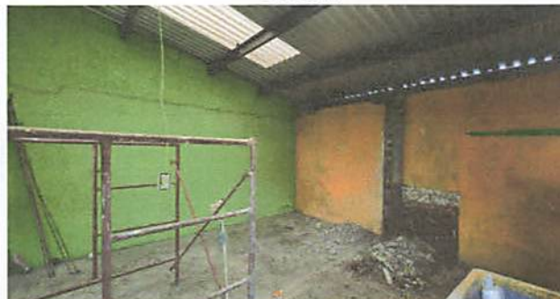
DEMOLICION DE PARED
