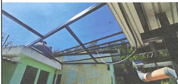
ESTRECTURA DE TECHADO
