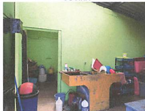
DEMOLICION DE PARED
