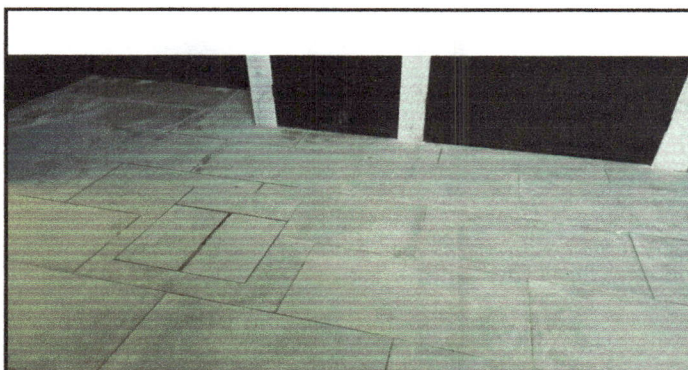
Foto 6: avance de la hechura de la cisterna
