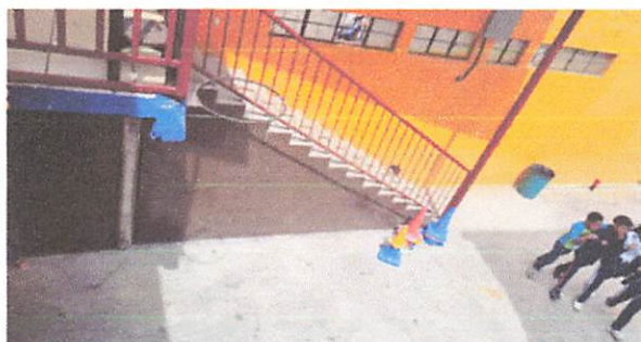
Foto 6: REPARACION DE ESPACIO DE DESECHOS CON PUERTA HACIA LA CALLE
