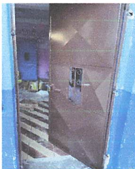
Foto 9: CAMBIO DE PUERTA DEL LABORATORIO DE COMPUTACION
