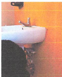
Foto 7: SUSTITUCION DE LLAVES DE AGUA EN LAVAMANOS
