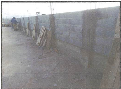
Llevantamiento de muro
