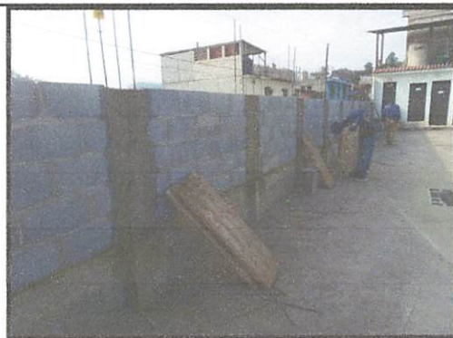
Fundición de columnas
