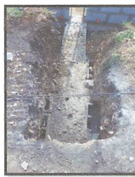
Jaladores del muro y preparación para la losa
