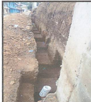
Proceso de sanjeo /preparación de zapata
