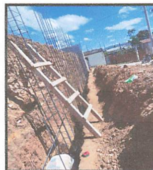
Proceso de sanjeo /preparación de zapata
