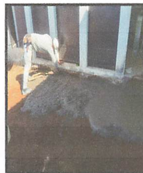
Fundición de losa
