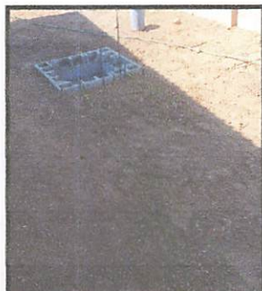
Preparación de la losa y reposadera
