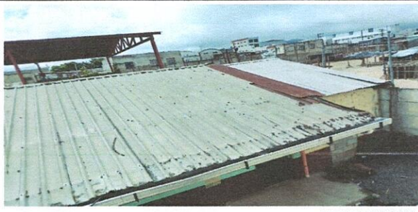
HONOR X7b 24mm f/1.75 1/890s ISO100 Foto 6: Techo de lamina la cual se ve deteriorada por el paso del tiempo
