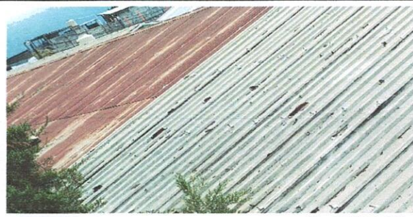
HONOR X7b 107mm f/1.75 1/770s ISO100 Foto 2: se puede evidenciar el oxido en las laminas.
