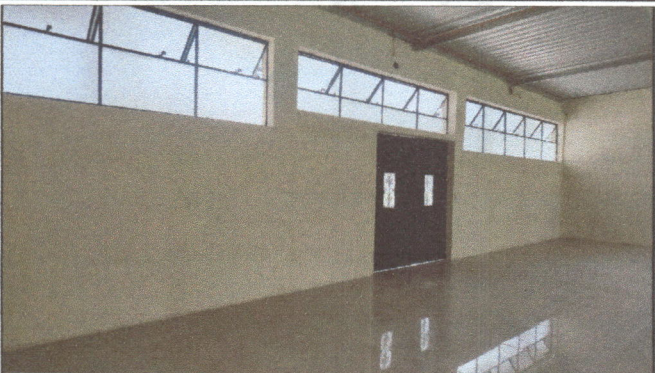
Foto 2: AMPLIACION DE PUERTA
