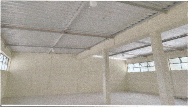
Foto 2: APERTURA CORRIENTE ELECTRICA
