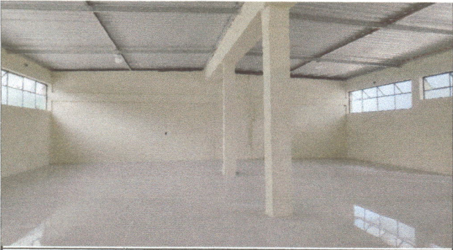
Foto 3: DEMOLICION DE PAREDES BAÑOS E INSTALACION DE VIDRIO
