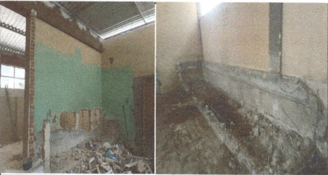
Foto 5: DEMOLISION DE PILAS
