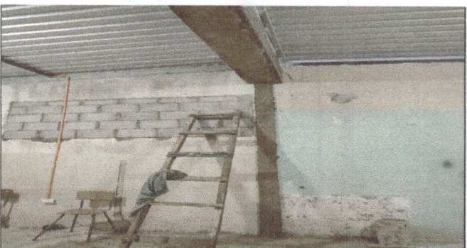
Foto 6: DESINSTALACION DE VENTANA, COLOCACION DE PARED Y CERNIDO
