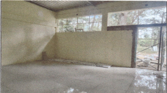
Foto 2: AMPLIACION DE PUERTA
