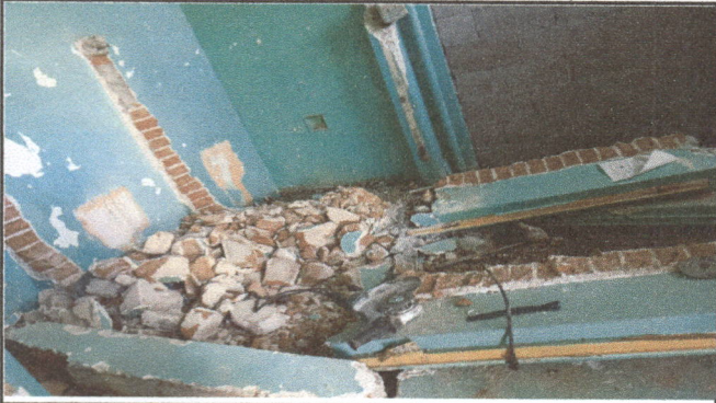
Foto 2: DEMOLICION DE PARED
