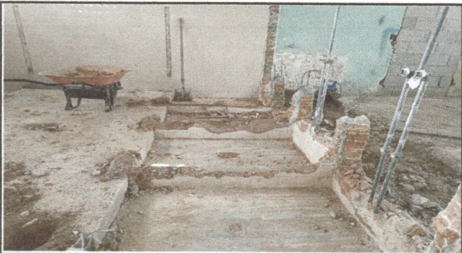
Foto 3: DEMOLICION DE PAREDES BAÑOS
