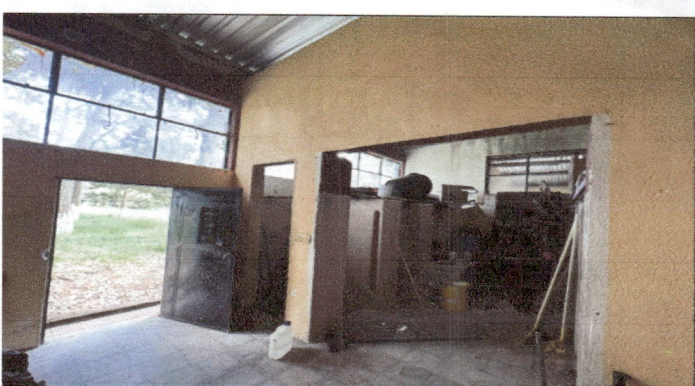
Foto 4: INSTALACION DE PISO Y PINTADO DE PAREDES
