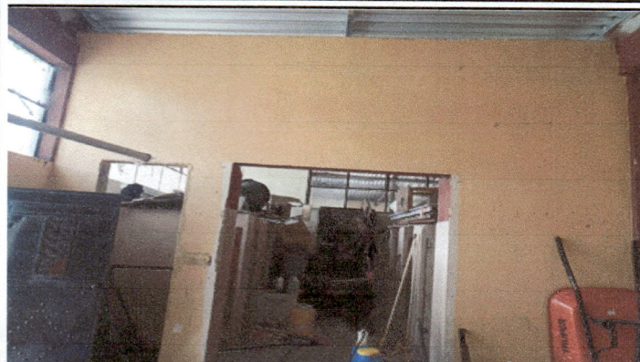
Foto 1: DEMOLICION DE PARED
