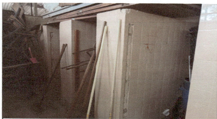
Foto 3: DEMOLICION DE PAREDES BAÑOS
