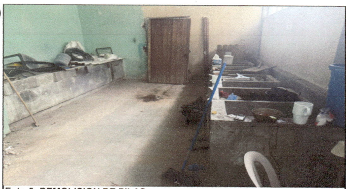
Foto 5: DEMOLISION DE PILAS
