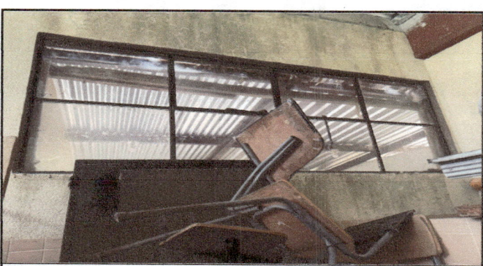
Foto 6: DESINSTALACION DE VENTANA, COLOCACION DE PARED Y CERNIDO
