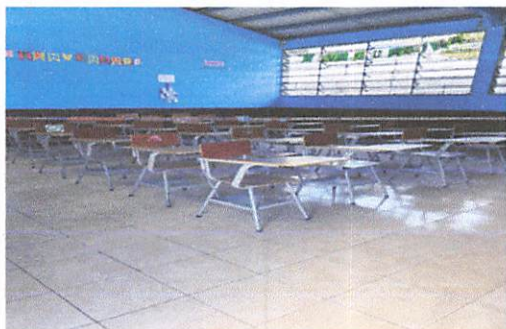
Foto1: Colocación de piso en salones
