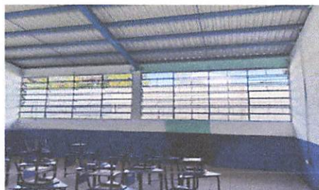
Foto 6: Mantenimiento de ventanas en mal estado
