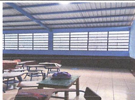
Foto 2: Colocación de vidrios
