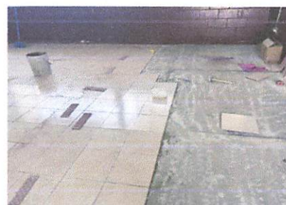
Foto 4: Colocación de piso en salones
