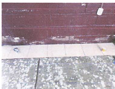
Foto 1: Colocación de piso en salones
