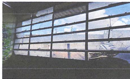
Foto 2: Colocación de vidrios
