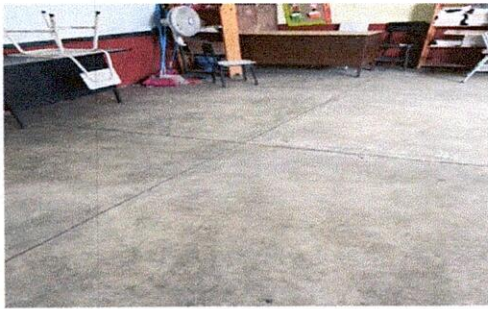
Foto1: Colocación de piso en salones
