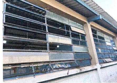
Foto 2: Colocación de vidrios
