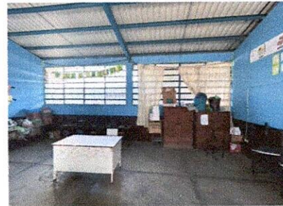
Foto 4: Colocacion de piso en salones
